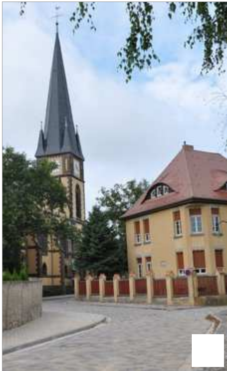
Straße und Fußwege in Richtung Kirche und Schule nach der Sanierung. Rechts das Pfarrhaus. | Foto: Falk Rockmann
